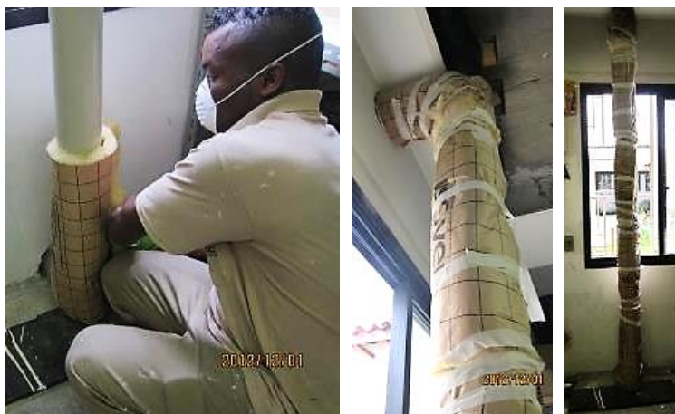
Figura 2 – Envolvimento da tubulação de PVC série R com lã de vidro de 15mm. Fonte: autores, 2016.
